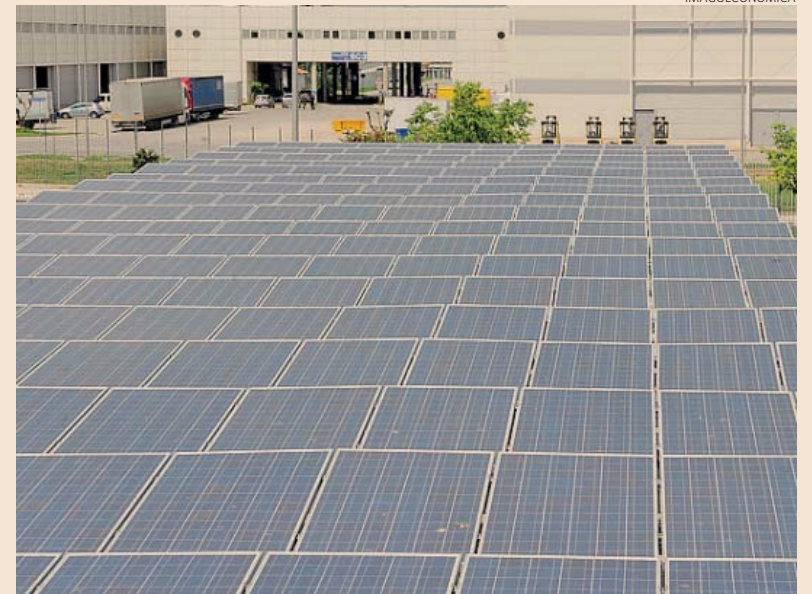
Un impianto di pannelli solari
